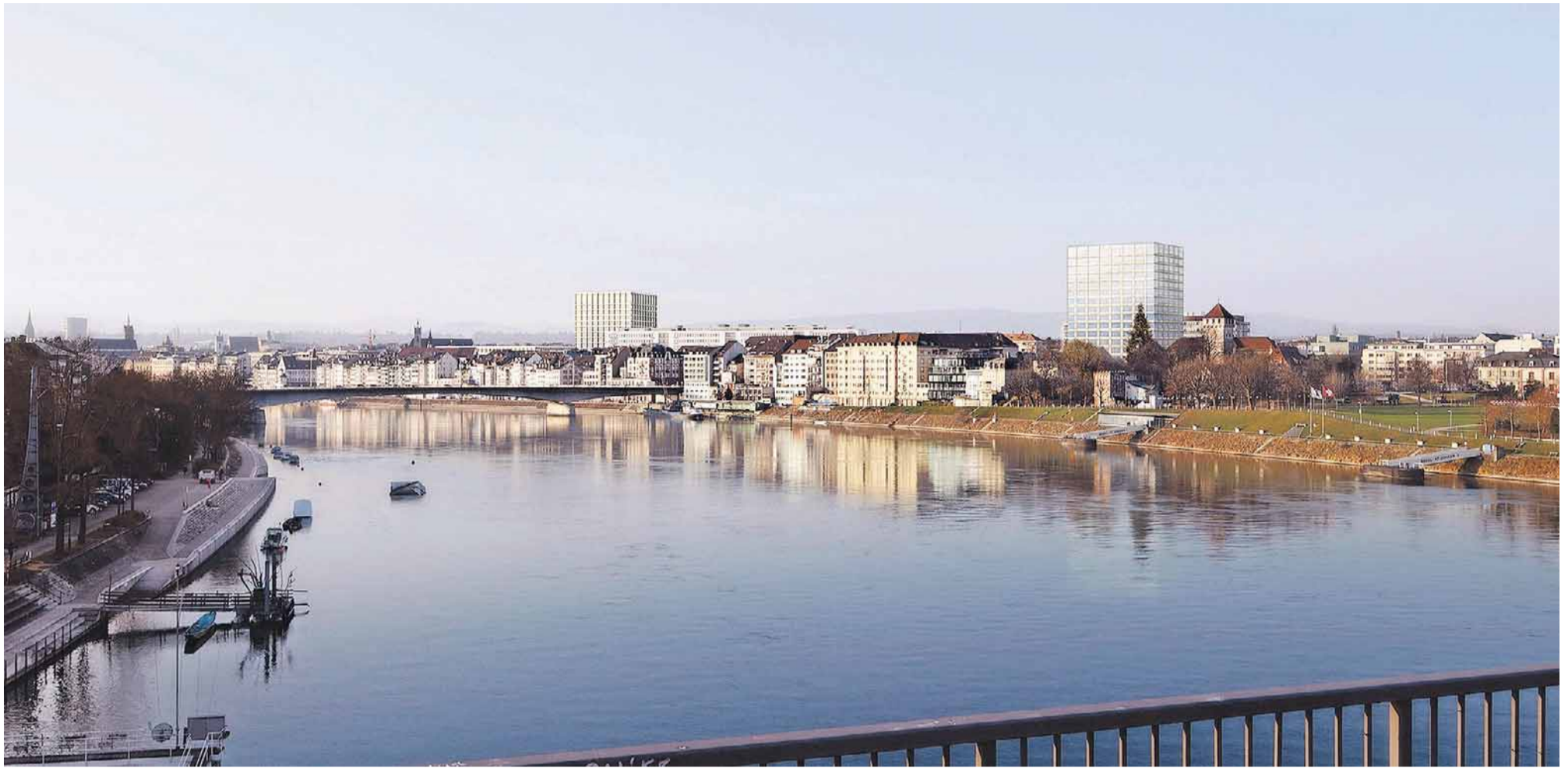
So wird künftig der Blick von der Dreirosenbrücke aussehen: Das 60-Meter-Hochhaus des Klinikums 1 (links) wird Gesellschaft vom Biozentrum beim St. Johanns-Tor erhalten. VISUALISIERUNG/ZVG
