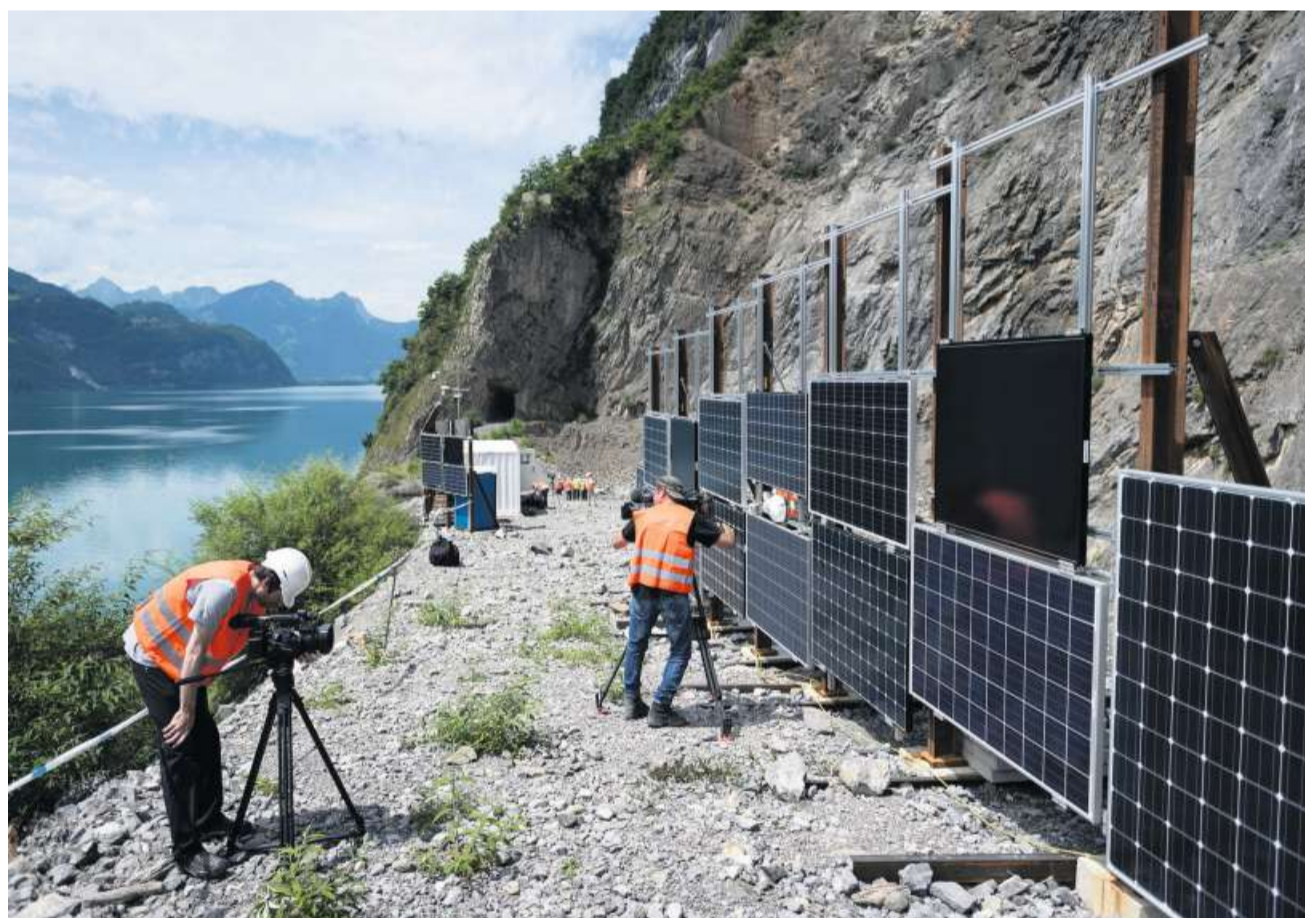
Der Testbetrieb am Walensee ist klein. Die Solargrossanlage soll aber die ganze Felswand (rechts) bedecken. GIAN EHRENZELLER / KEYSTONE
