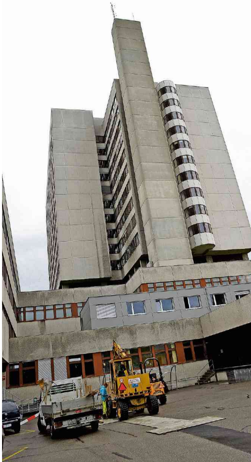
Einer von drei Standorten des KSBL - heute noch: Das Bruderholzspital. MARTIN TÖNGI
