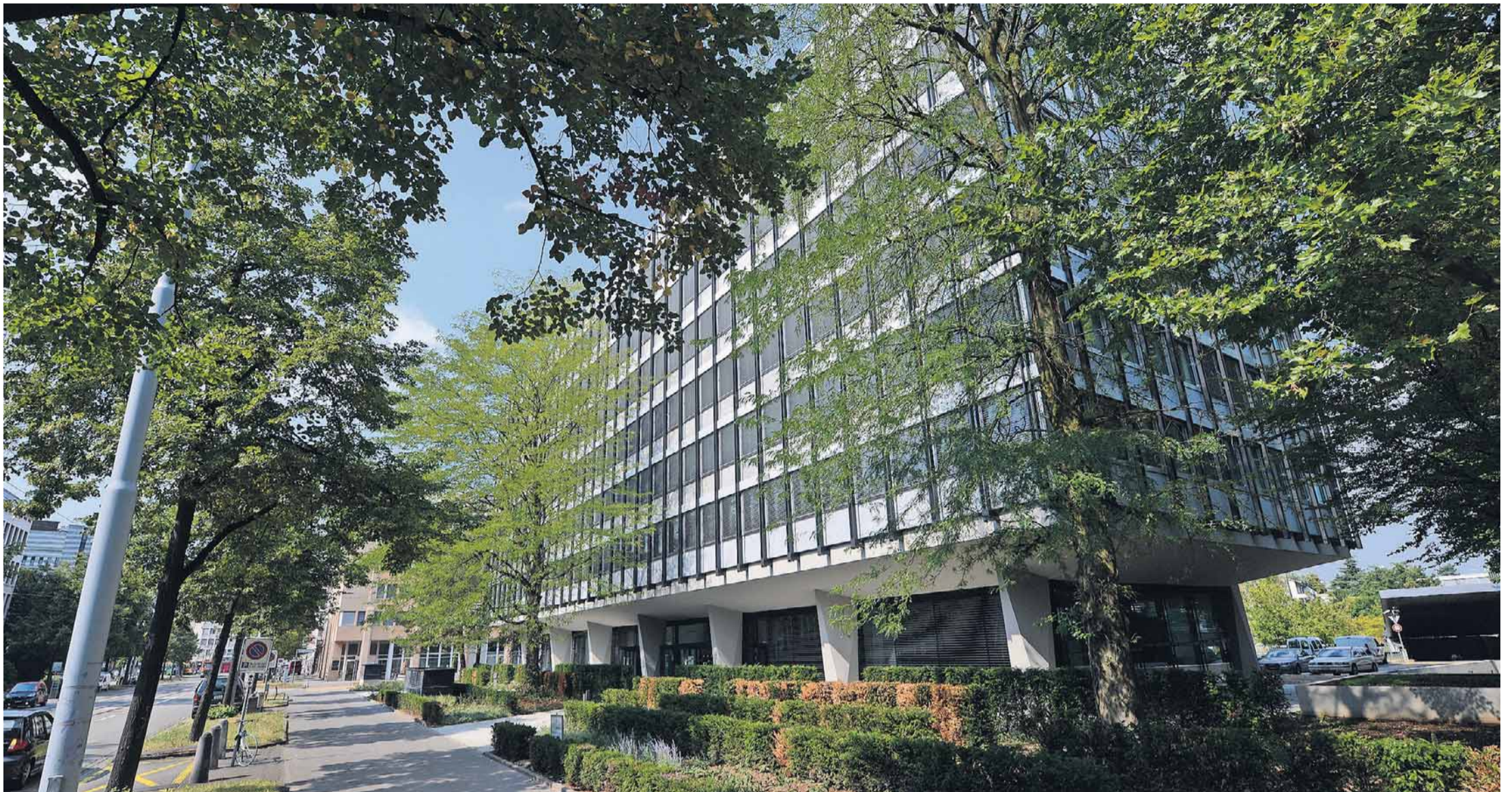
Erdbeben- und brandsicherer: Das sanierte Bürogebäude der Architekten Suter & Suter aus dem Jahr 1963.
