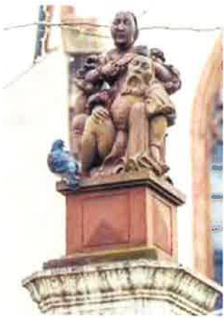
Sandstein ist besonders empfindlich gegenüber Taubenkot, der Denkmalschutz ist in Bezug auf die Taubenproblematik ebenfalls gefragt.
